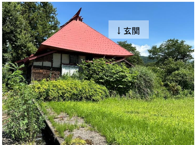
母屋の南側から(手前の土地は別所有者)
