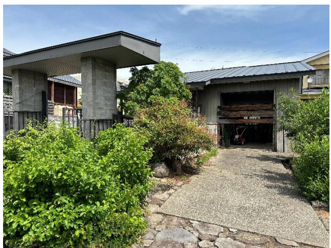
離れ外観(同一の敷地内)
