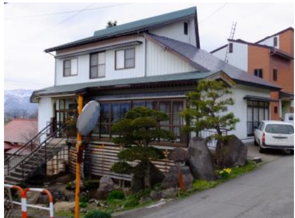
居宅 駐車スペース↑
