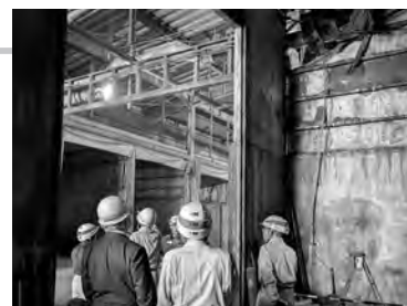
堆肥センターの 長寿命化工事の現場確認
