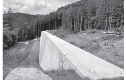
土砂災害を防ぐ砂防ダムのえん堤
