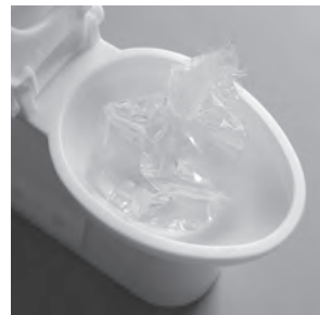
逆流・悪臭対策 排水口も同様に
