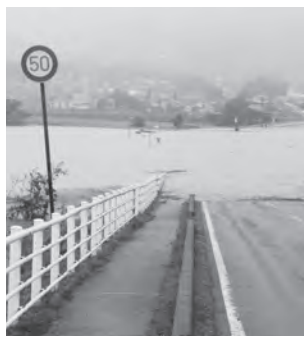
▲令和元年10月 新橋付近冠水の様子
