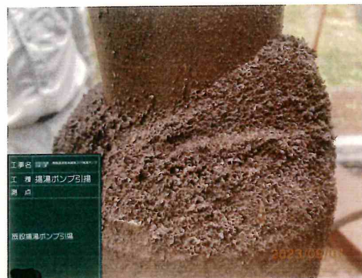
写真 4.1.2 フランジ面砂の堆積
