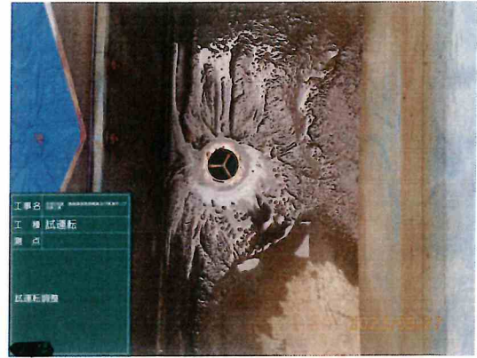
写真 5.2 揚湯直後 揚砂確認
