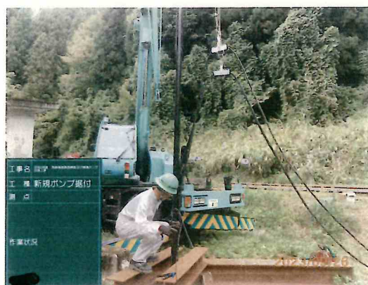
写真 4.2.4 据付作業状況
