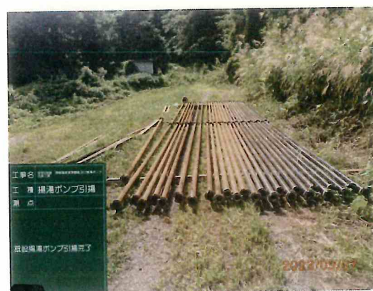
写真 4.1.5 揚湯管引揚完了
