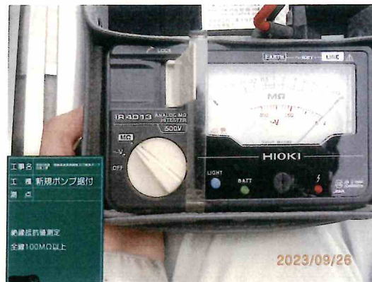
写真 4.2.2 絶縁抵抗値 全線 100MΩ以上
