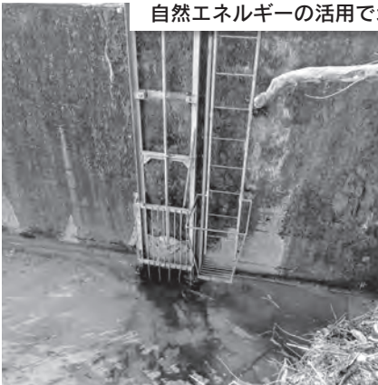
馬曲川水力発電所の取水口 (左) とごみ取り装置 (右)
