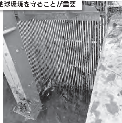
馬曲川水力発電所の取水口 (左) とごみ取り装置 (右)
