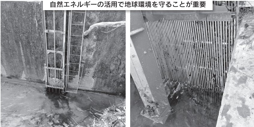
馬曲川水力発電所の取水口 (左) とごみ取り装置 (右)
