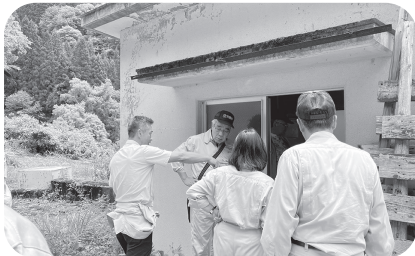
源泉のポンプを確認
