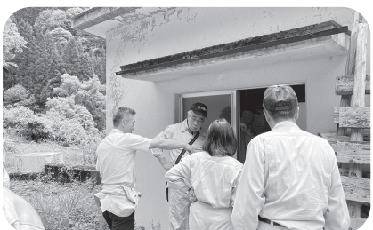
源泉のポンプを確認
