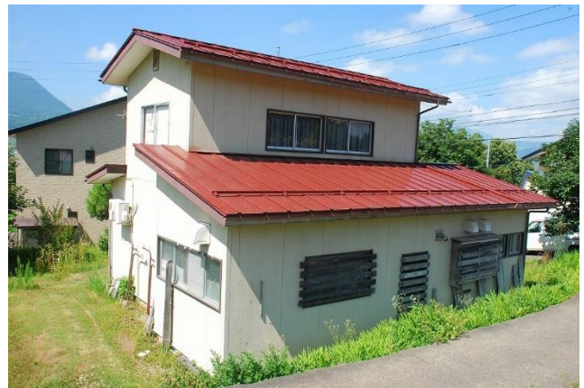
建物外観（北側）
