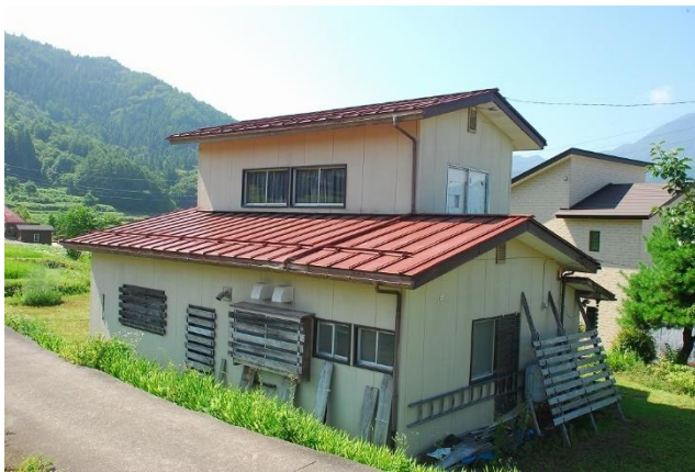
建物外観（北側）
