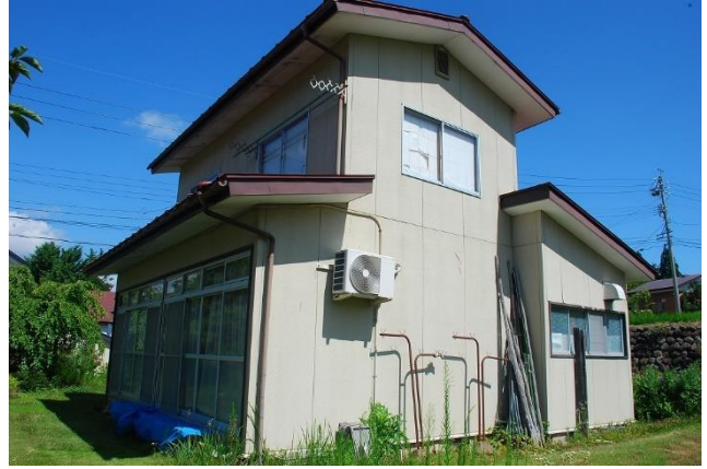
建物外観（東側）
