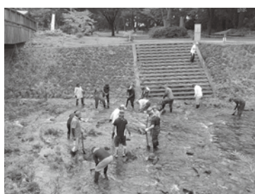
▲作業中の様子
