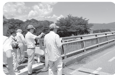
今年度修繕が計画されている越渡橋
