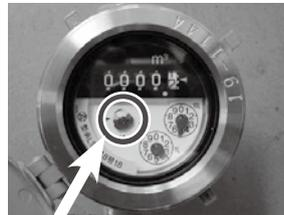
矢印の部分が家中の水を止めても回っている場合は漏水です。水道メーターは量水器ボックスの中にあります。
