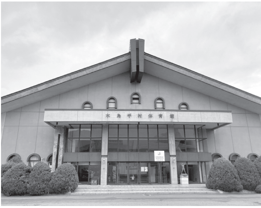
昭和50年に建てられた村体育館
