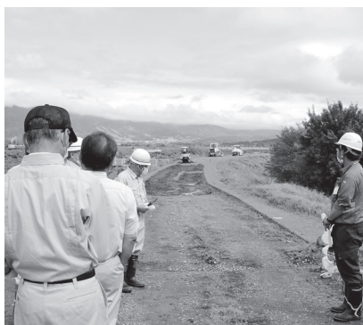
堤防の天端舗装（菜の花橋から蛭川橋まで）工事前
