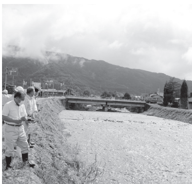
樽川の浚渫（川底に堆積した土砂を取り除く）工事後
