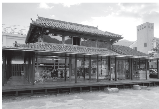
写真1 築90年の古民家を改修したえんがわオフィス
