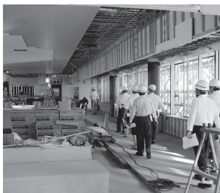
1階 内装工事の様子
