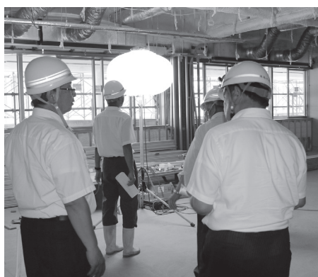
2階会議室 内装工事の様子
