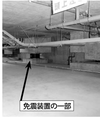
天竜区役所【地下の免震設備・空調室】
