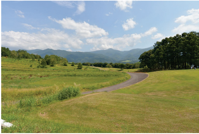
木島平 0002 盛土造成地上端
