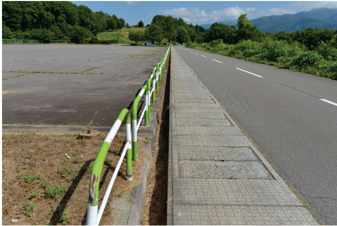
木島平 0003 盛土造成地上面
