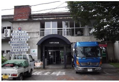
取り壊される村民会館
