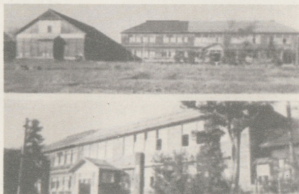
旧南校舎東側増築直後（昭和32年7月撮影）
